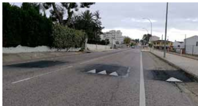
Fotografía de "cojín berlinés". Ejecutado con aglomerado asfáltico.
