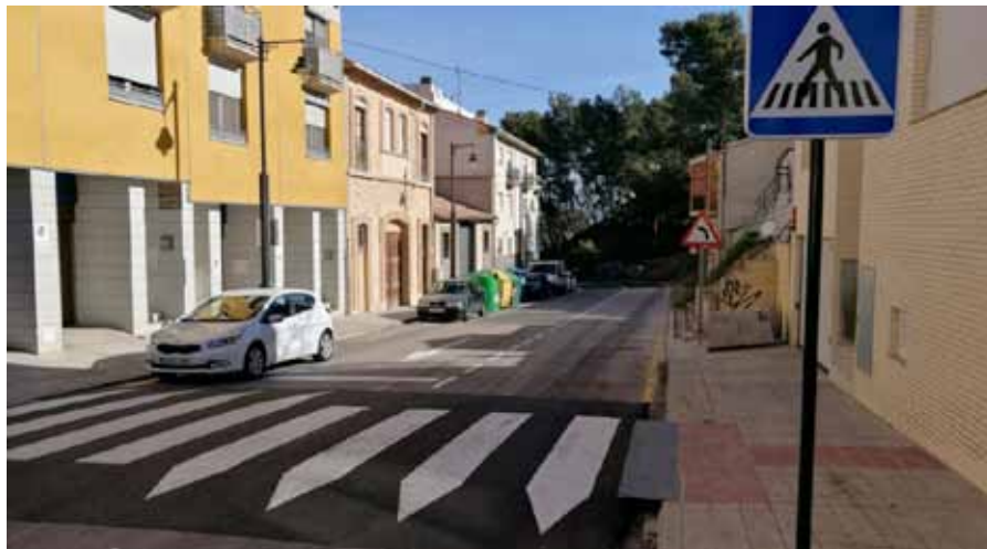
Paso peatonal sobreelevado.
