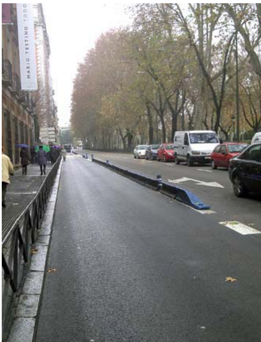
Foto 4: Carril bus separado y protegido.
