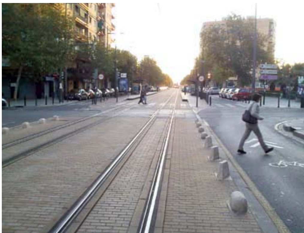
Foto 2: Sección de calle con reparto de usos más equitativo. Tranvía central, calzada compartida entre vehículos y bicicletas, y aceras laterales.
